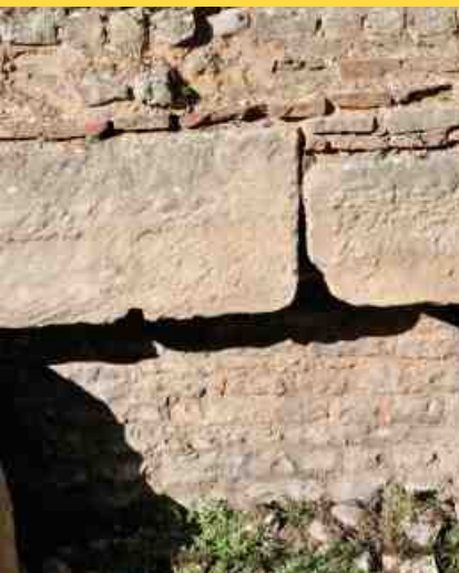
Détail des fondations de l'enceinte antique
