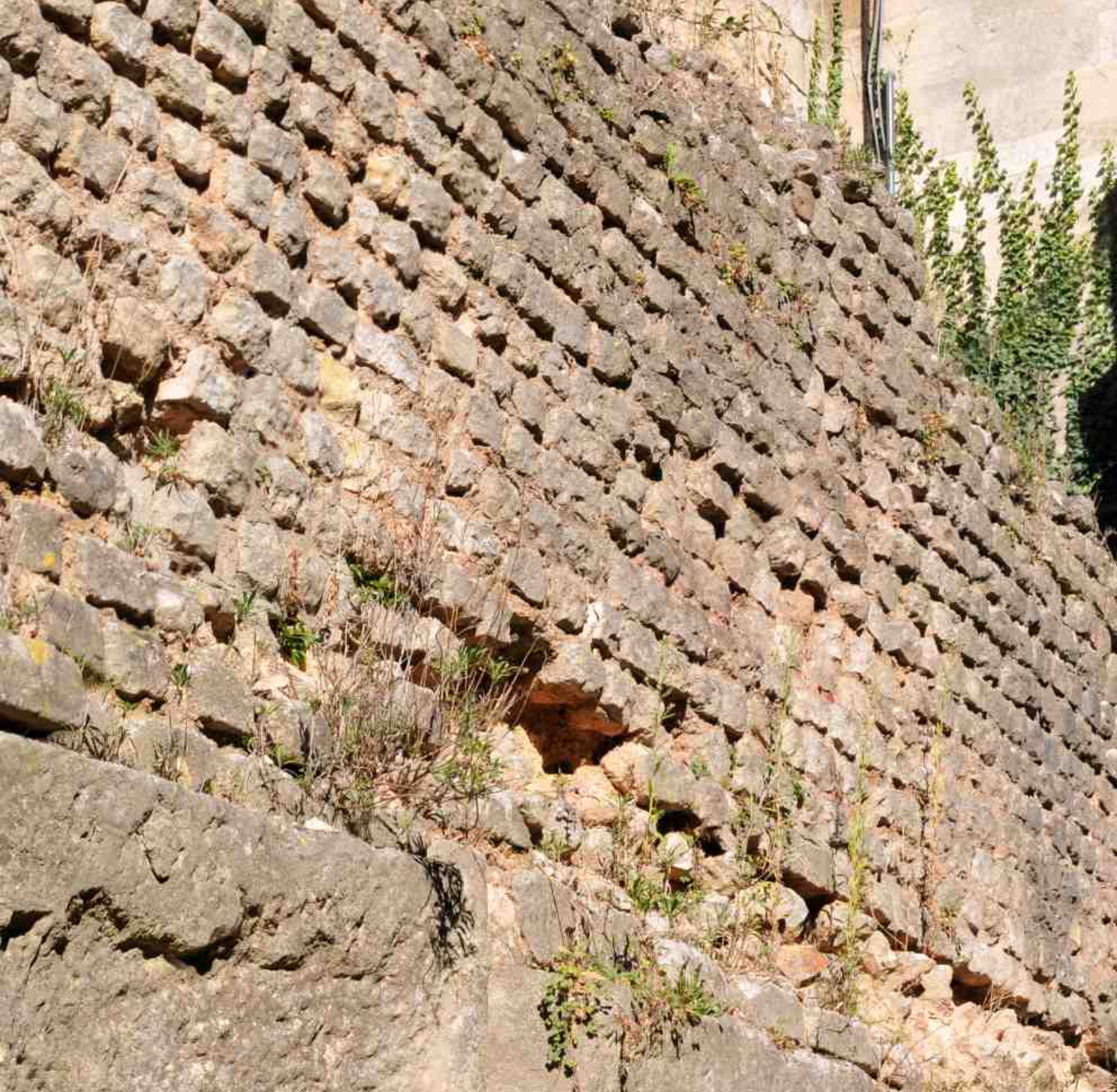
Vue actuelle des vestiges de l'enceinte antique, rue des cordeliers
