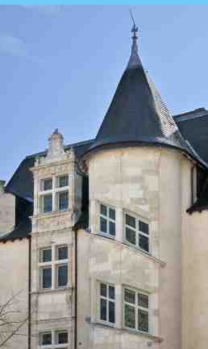
Tourelle de l'escalier à vis en hors œuvre
