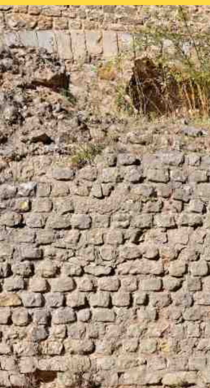
Détail de l'élévation en petit appareil
