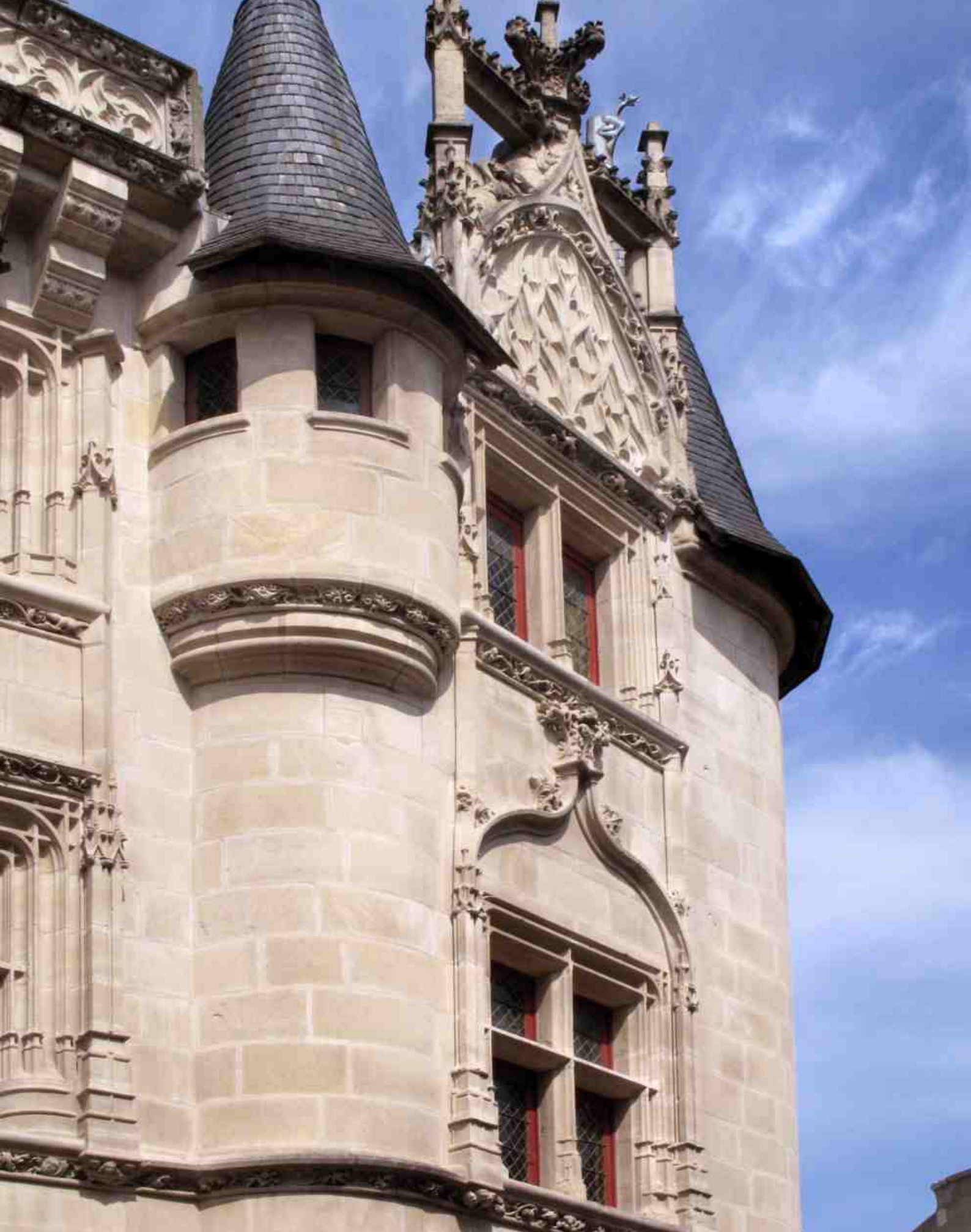
Façade de l'hôtel Fumé
