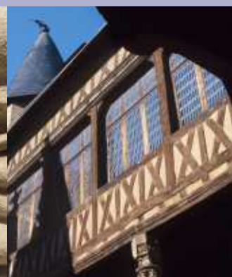
Étage supérieur de la galerie
