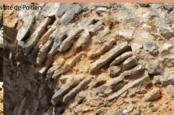
Détail de la voûte
