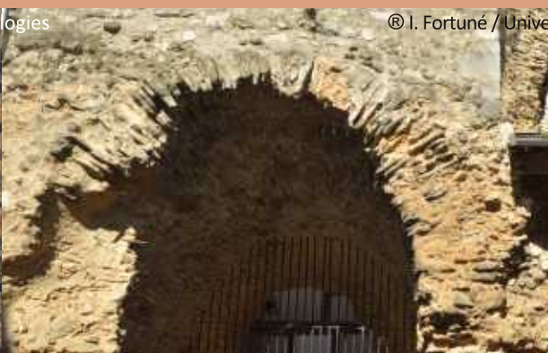
Vestiges de voûte rue Bourcani
