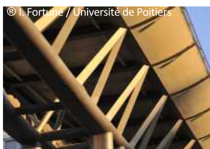
Détail du tablier du viaduc
