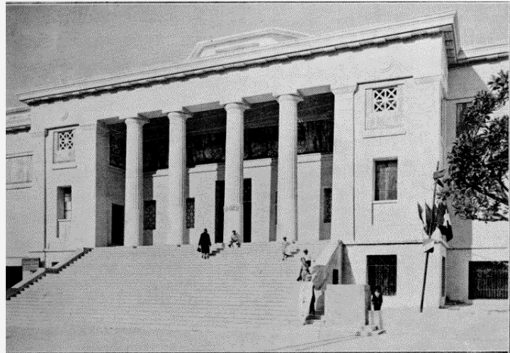
Georges Wolff (architecte D.P.L.G., Saint-Etienne 1873 - Nice 1970), Escalier monumental d'entrée du Palais des Beaux-Arts d'Oran, photo A. Luck et fils, Oran (source : Chantiers nord-africains , 1930, p. 663).
